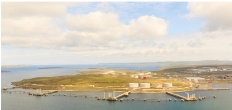
Sullom Voe Terminal
